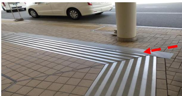
そのため周りの地面と隙間を作る必要があります。その隙間を解消するため金属板でカバーしています。
